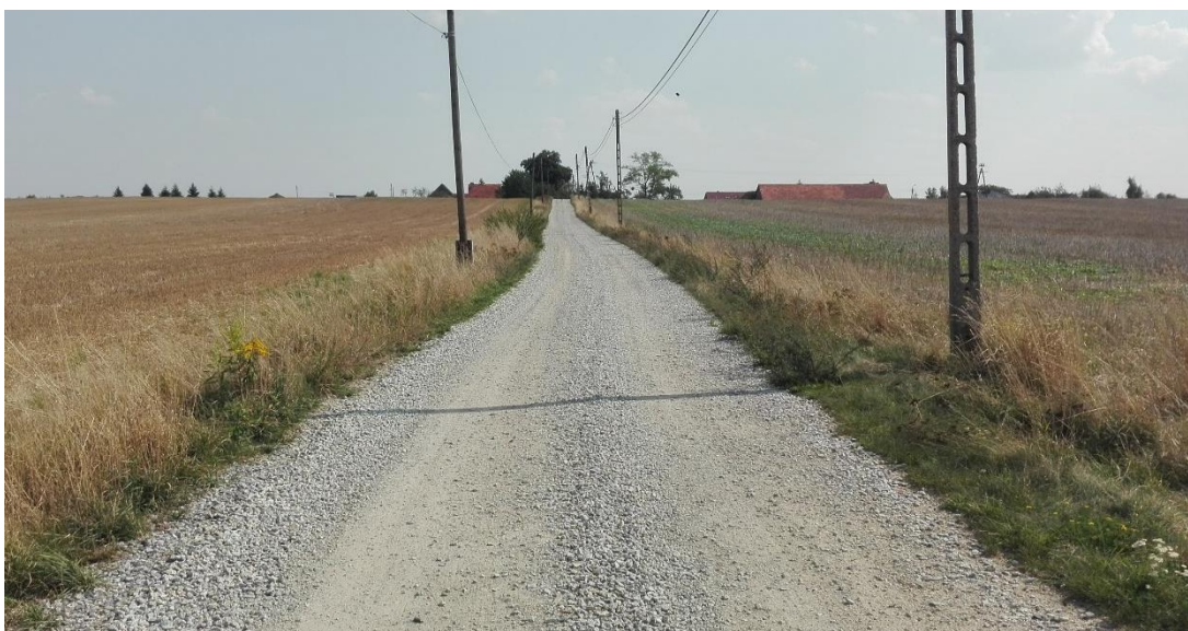
Droga po naprawie kruszywem drogowym
