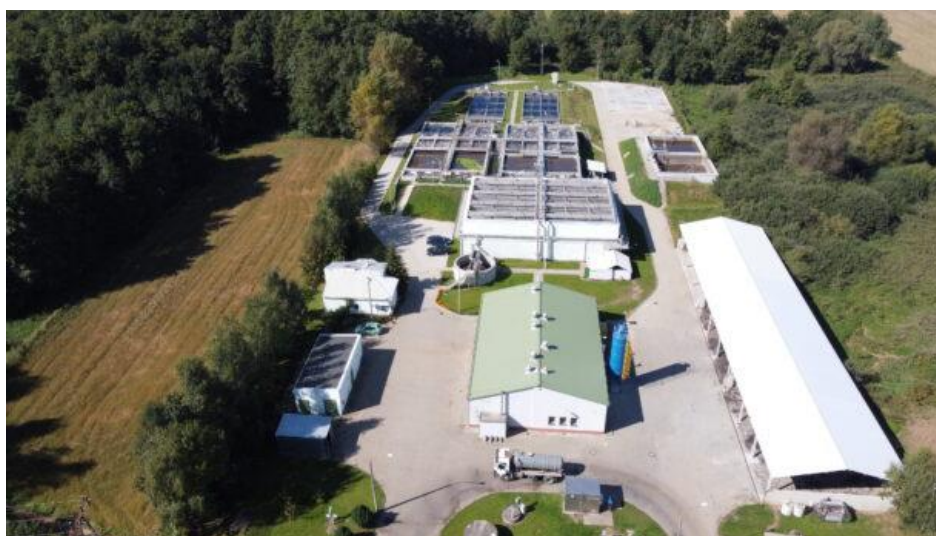
Komunalna oczyszczalnia ścieków w Jurczycach
