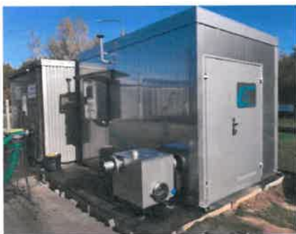
Fot. Modernizacja stacji zlewnej na terenie oczyszczalni ścieków w Jurczycach
