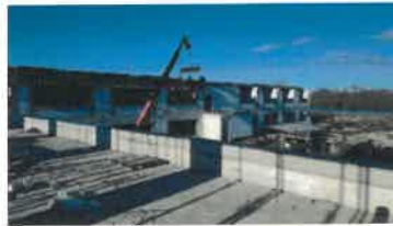
Fot. Widok z budynku A4 na budynek B
