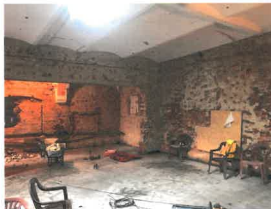
Fot. Remont świetlicy w Zabrodziu
