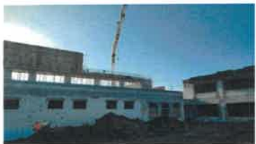
Fot. Widok na budynek A3 i A4
