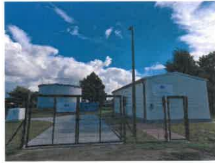
Fot. Stacja uzdatniania wody SUW Smolec
