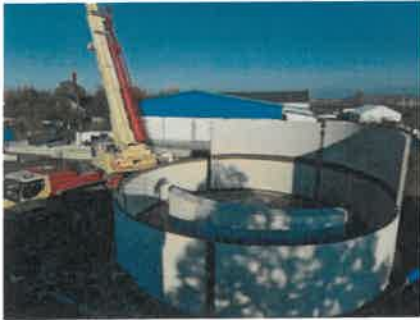
Rys. Budowa zbiornika wody czystej w miejscowości Smolec
