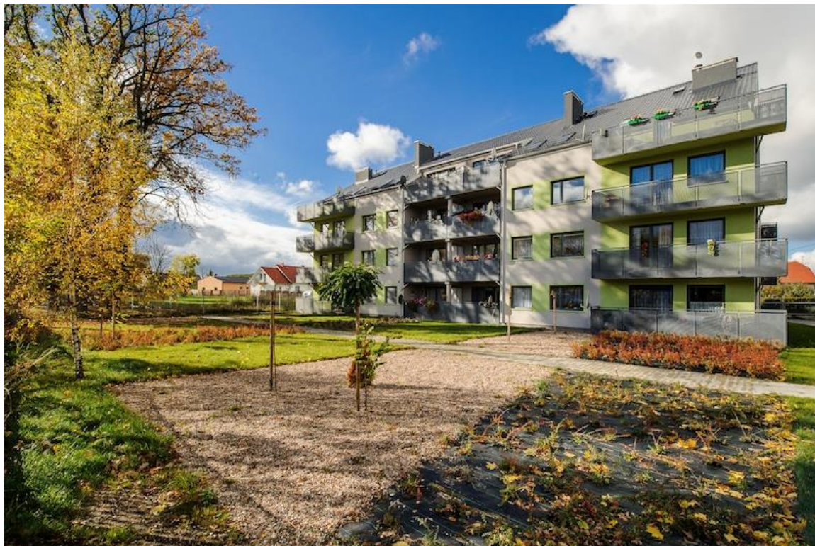
Budynek komunalny w Kątach Wrocławskich
